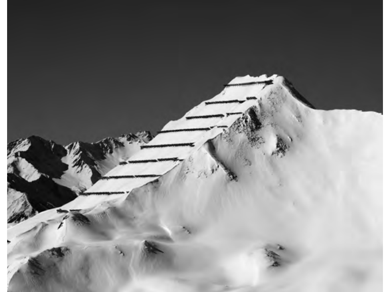
Stützverbauungen im Anrissgebiet des Chüenihorns in St. Antönien: Von 1953 bis 1977 wurde nach der grossflächigen Zerstörung des Bannwalds oberhalb des Dorfs eine der grössten Lawinenschutzverbauungen der Schweiz errichtet. Die Werke haben eine Gesamtlänge von etwa 17 km.
