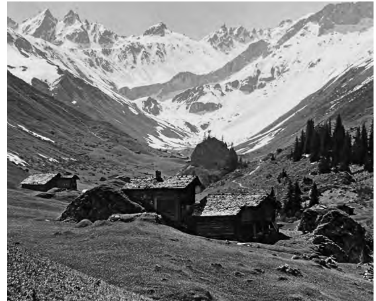
Schindelbedeckte Walserhäuser in Gafien mit dem Schlangenstein im Hintergrund: Es ist denkbar, dass die ersten ganzjährigen Niederlassungen der Walser in Gafien gebaut wurden.
