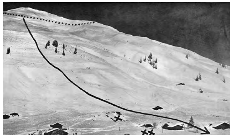
Die Zürcher Illustrierte berichtete ausführlich über das tragische Ereignis: Das zerstörte Haus Enzian (XX) und der Hof Matta (X) unter dem waldfreien Chüenihorn
