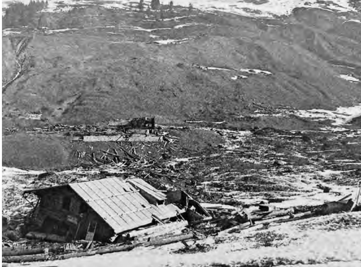
Ein Bild der Zerstörung: Im Vordergrund ist das Haus Enzian sichtbar, in welchem vier Personen ihr Leben verloren. Trotz dem «Ebenhöchs», welches aber nicht bis zum Dach reichte, wurde das Haus Enzian von der Lawine total beschädigt. Im Hintergrund sind die Trümmer vom Haus Matta ersichtlich – auch darin fanden leider drei Personen den Lawinentod.
