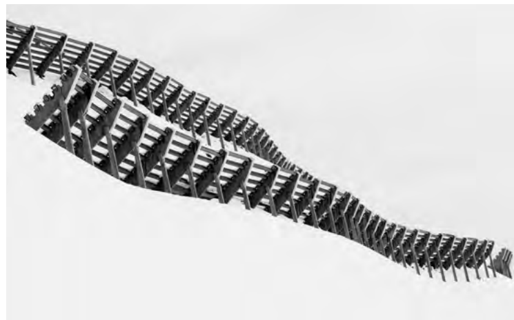
Stützverbauungen am Chüenihorn
